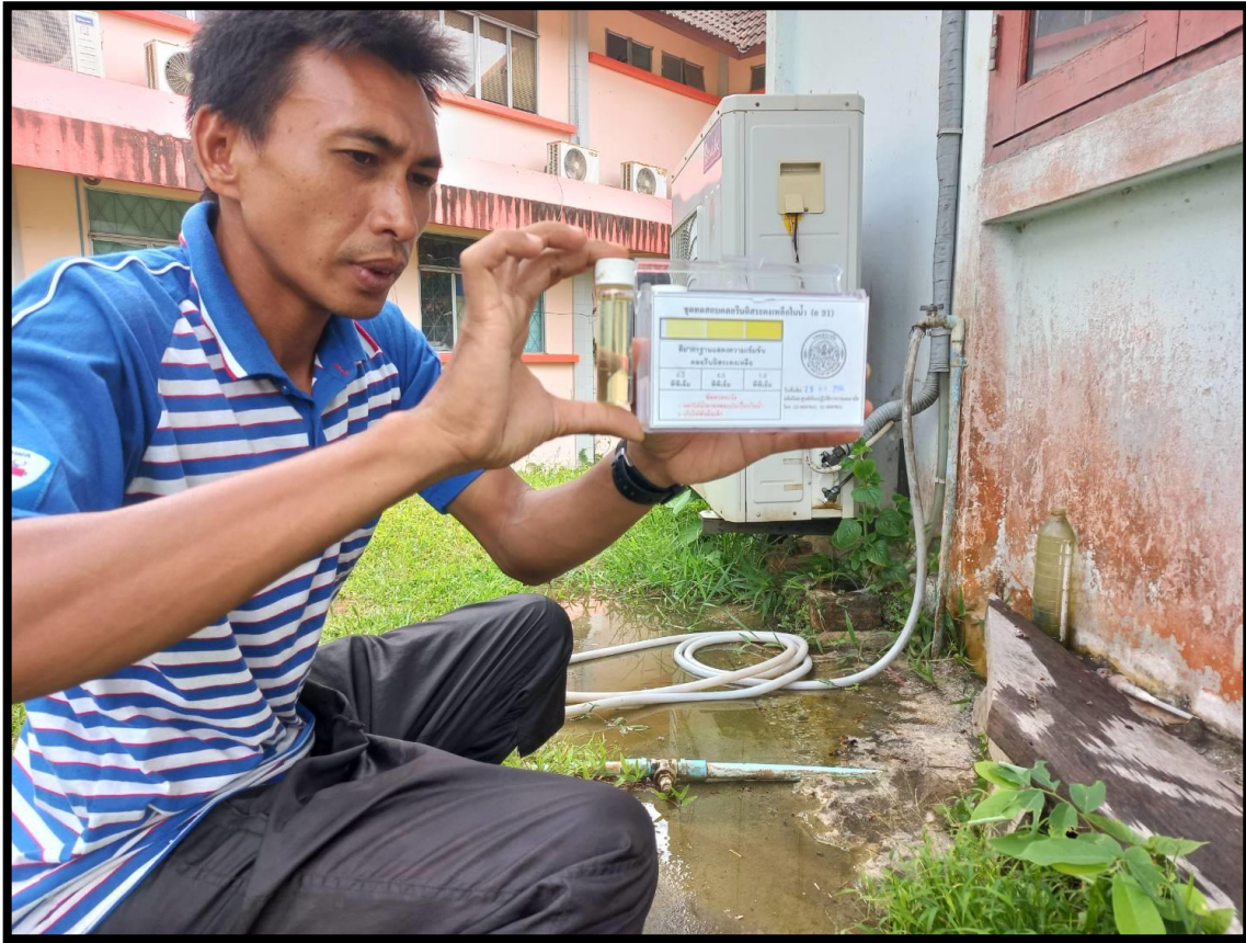
รูปภาพการตรวจคุณภาพน้ำประปาภาคสนาม ประจำเดือน มีนาคม พ.ศ.2567
