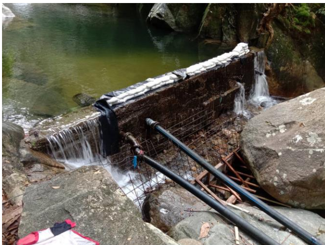
๙. โครงการปรับปรุงซ่อมแซมฝายกักเก็บน้ำประปาเทศบาลตำบลปะลูปบนน้ำตกฉัตรวาริน
